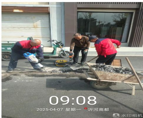
沿街管道维修
