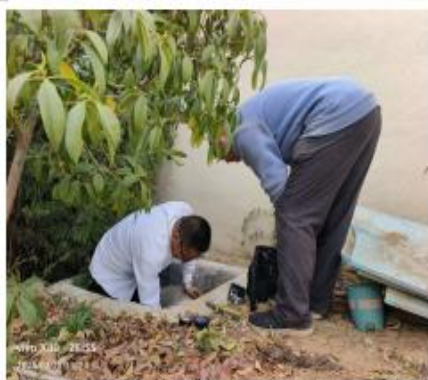
帮业主维修水泵
