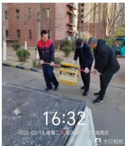
帮业主维修水泵
