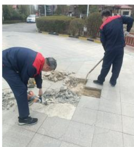
维修园区破损路面
