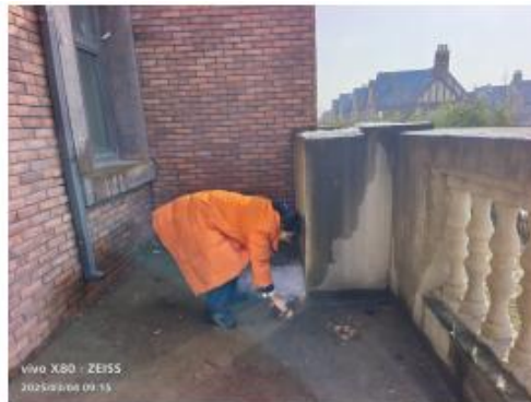
空置房天台地漏检查
