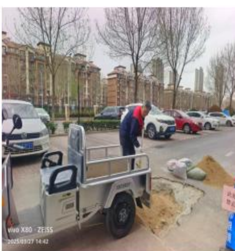
漏点维修后路面修复
